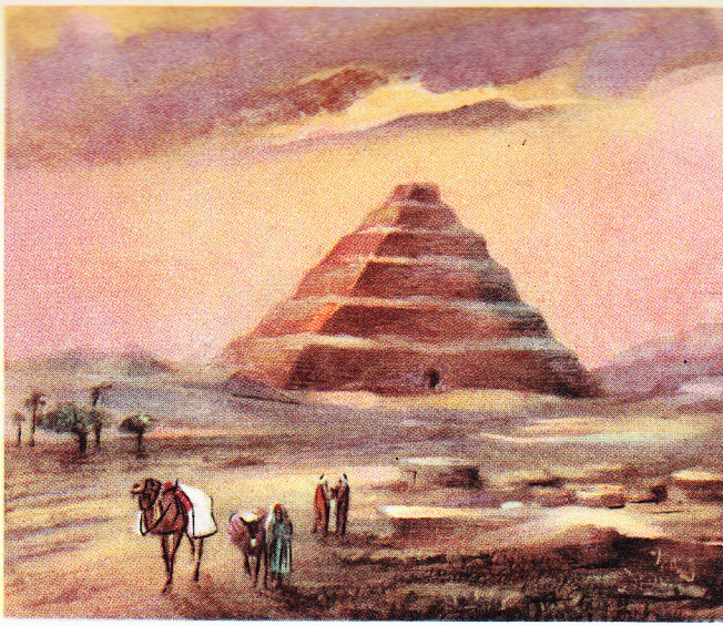
La pyramide en gradins du pharaon Soser s'élève à Sakkarah. Elle comprend six mastabas superposées. Plus tard, par l'adjonction de dalles latérales, on obtiendra quatre plans inclinés lisses, triangulaires, se rejoignant au sommet, et constituant par conséquent la pyramide parfaite.
